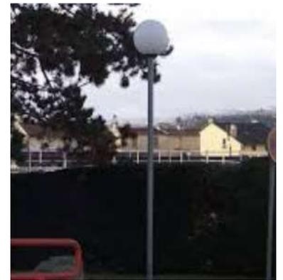
*Luminaires ouverts et luminaire boule équipés de lampes à vapeur de mercure*
