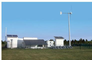
**Lauréat Énergie :** **SAGES: Smart Autonomous Green Energy Station**, station capable d'utiliser toute forme d'énergie renouvelable (vent, soleil, hydro...). Pour pallier à l'intermittence des énergies renouvelables et garantir à l'utilisateur une énergie fiable quelles que soient les conditions météo, présentée par **POWIDIAN** (Pavillon 3, H68)
